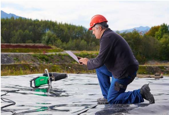
einer gewissen Unterspannung bei gleicher Leistung und Qualität zuverlässig schweisst. Wird die Unterspannung zu hoch, schaltet der Extruder automatisch ab, weil dann die Schweißqualität nicht mehr gewährleistet ist. Dank Eco-Modus sparen Anwender:innen in Arbeitspausen bis zu 40 % Energie.
